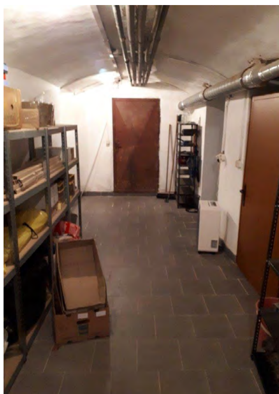
1.PP - část po rekonstrukci
