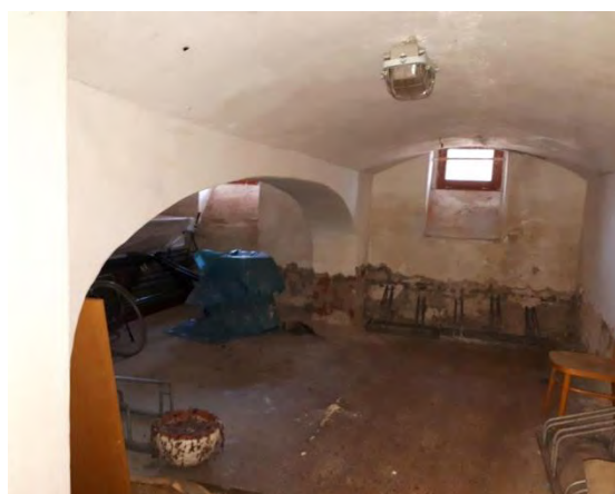
1.PP - část v původním stavu
