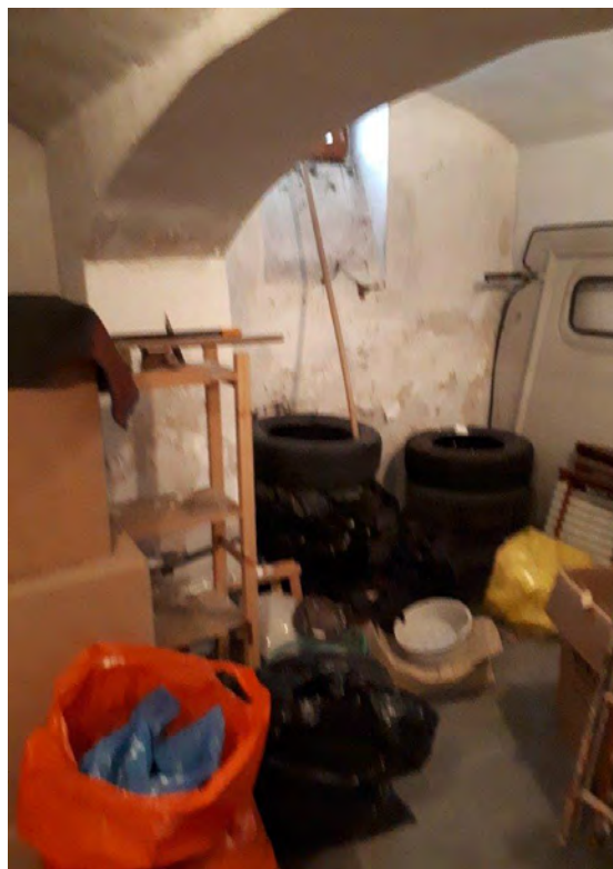
1.PP - část po rekonstrukci
