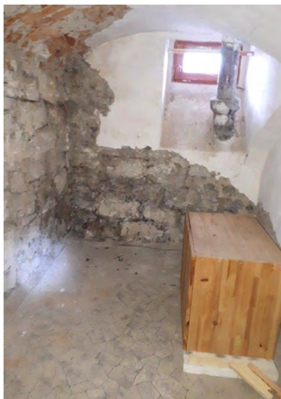
1.PP - část v původním stavu
