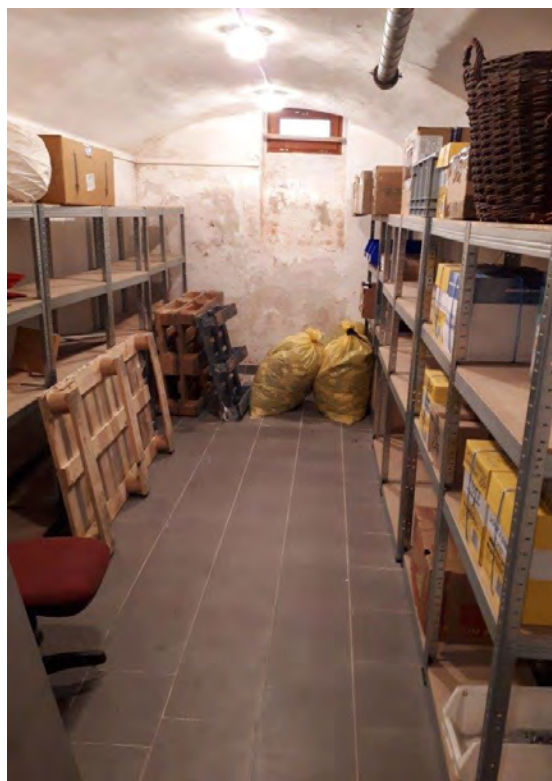
1.PP - část po rekonstrukci
