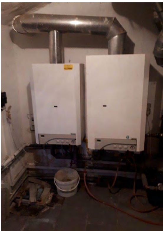
1.PP - část po rekonstrukci
