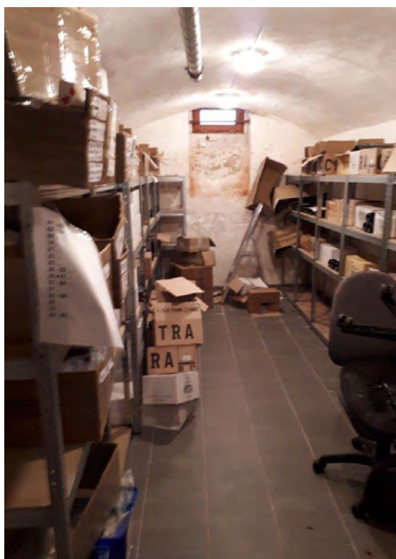
1.PP - část po rekonstrukci
