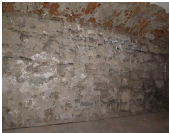
1.PP - část v původním stavu
