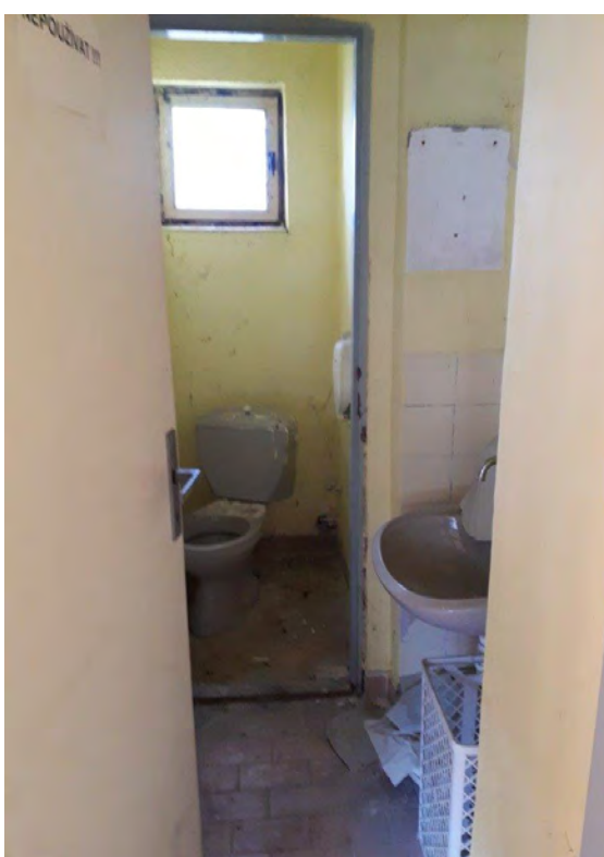
1.NP - vedle vstupního prostoru před prodejnou - 1. místnost
