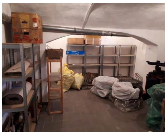
1.PP - část po rekonstrukci
