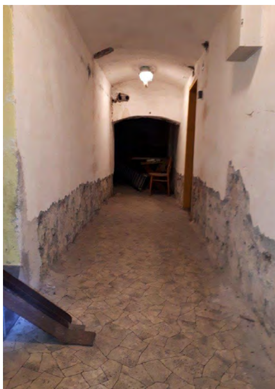
1.PP - část v původním stavu
