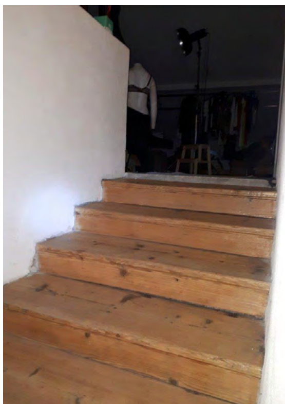
Podkroví - vstup do ateliéru
