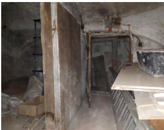
1.PP - část v původním stavu
