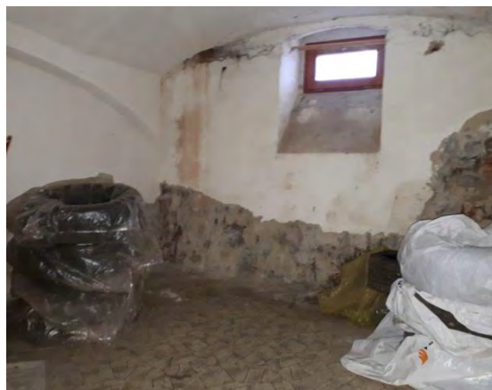
1.PP - část v původním stavu
