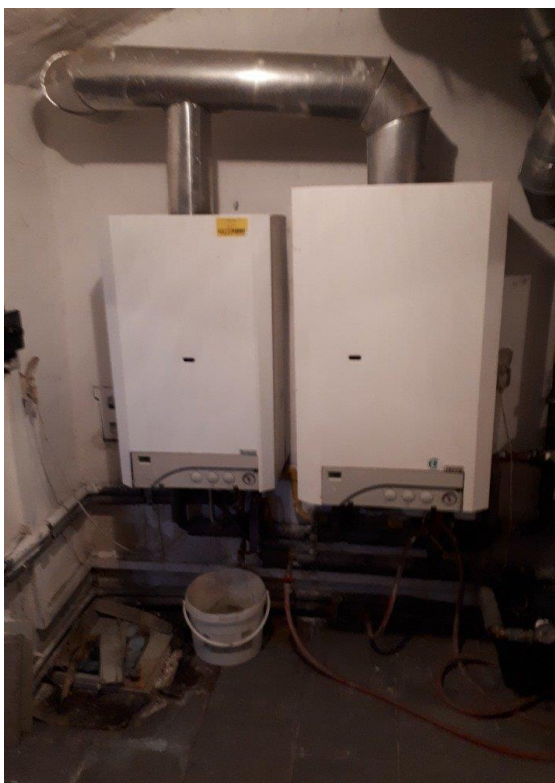
1.PP - část po rekonstrukci
