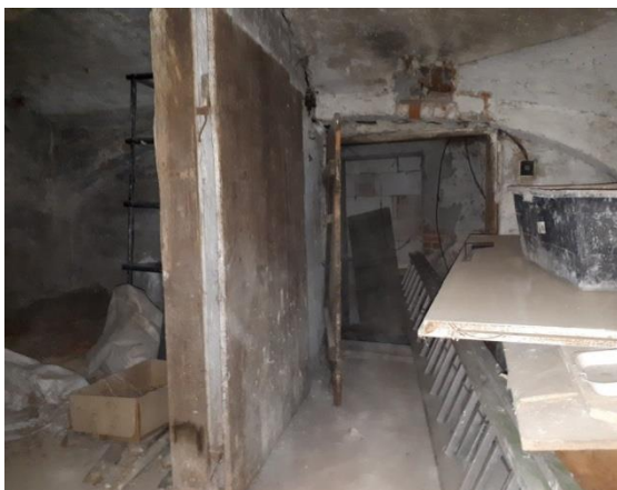
1.PP - část v původním stavu
