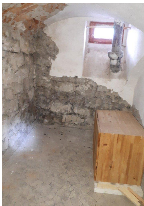
1.PP - část v původním stavu
