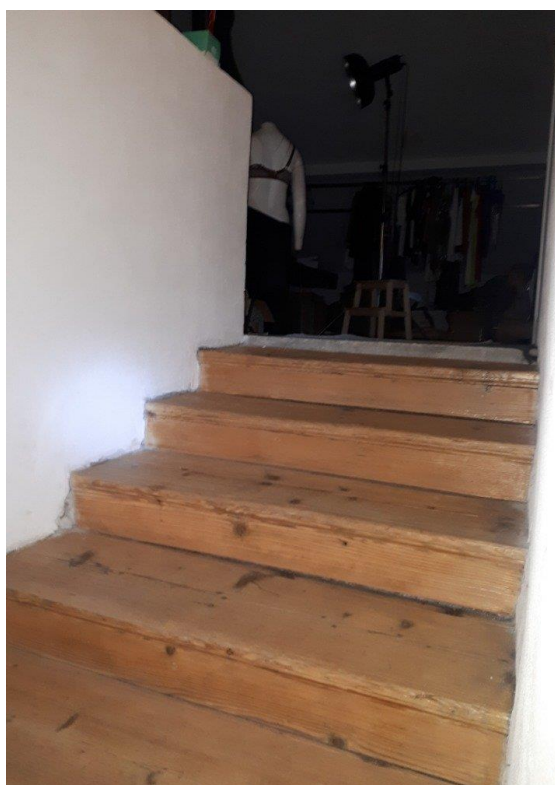
Podkroví - vstup do ateliéru
