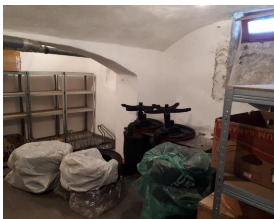
1.PP - část po rekonstrukci
