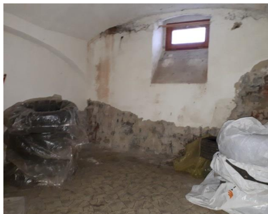
1.PP - část v původním stavu
