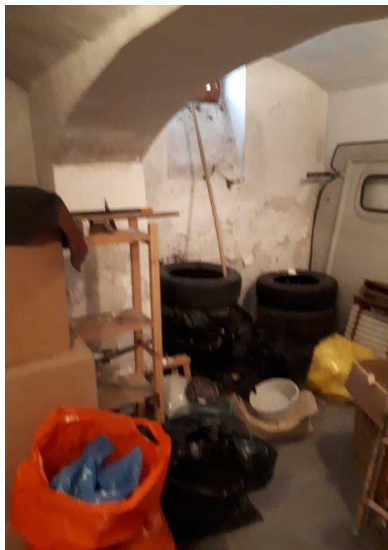
1.PP - část po rekonstrukci
