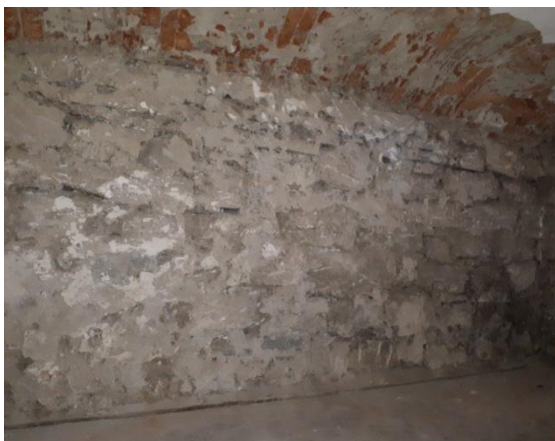
1.PP - část v původním stavu
