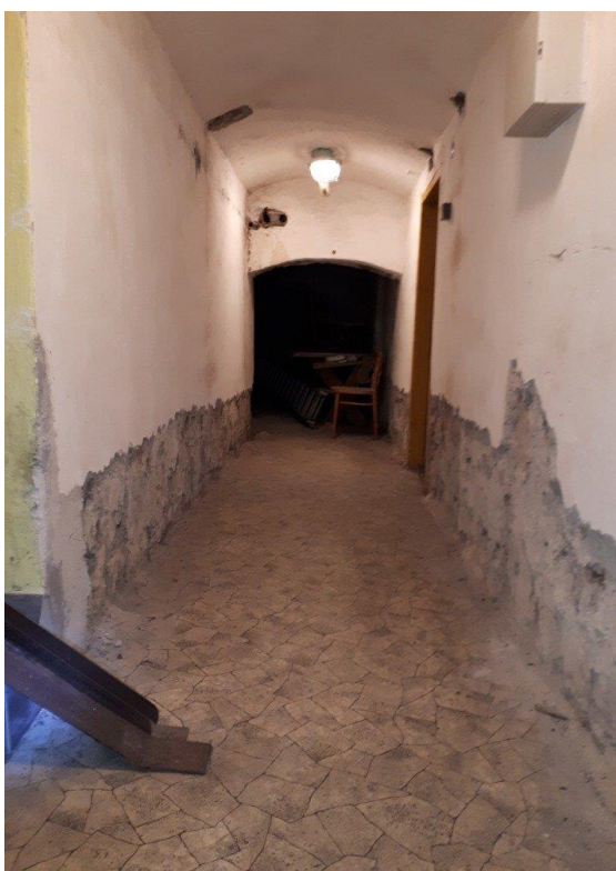
1.PP - část v původním stavu
