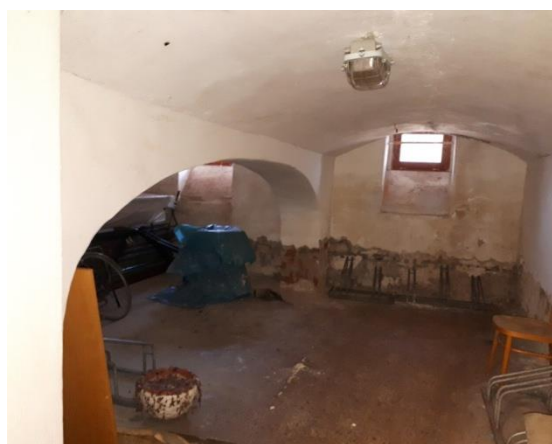
1.PP - část v původním stavu
